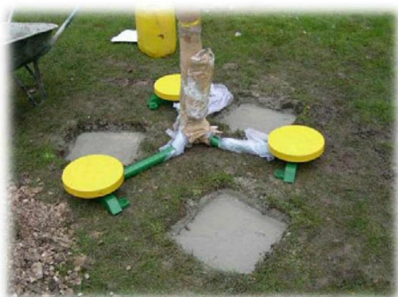
Body tripode à côté des plots béton sur lesquels il sera chevillé.
